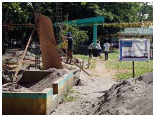
図書館の建設現場
