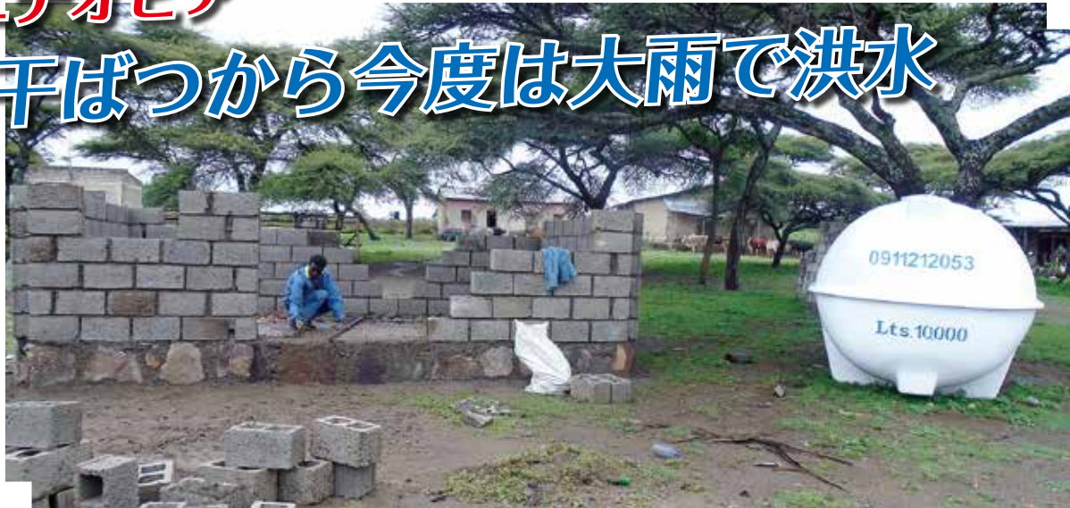
川や池などの水源から水を汲み上げるポンプ設備を建設中
