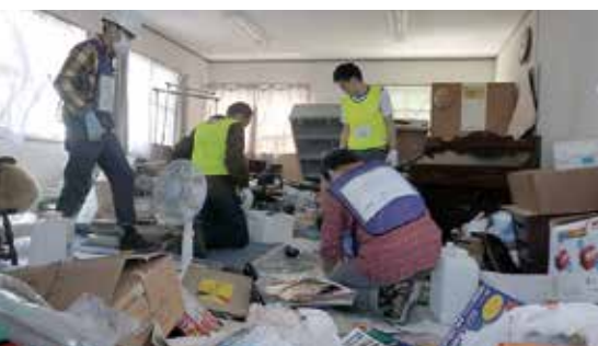
家財の片付けは住人の立会いのもとで（熊本支援センター）
