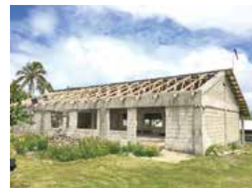
再建中の教会堂
