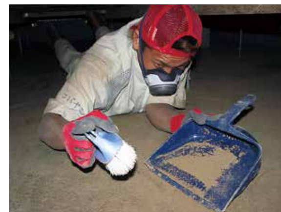
住宅の床下に堆積した泥を除去するボランティア（安佐南区八木）
