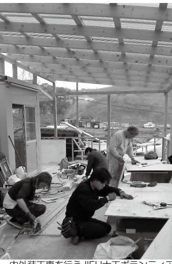
内外装工事を行うJIFH大工ボランティア
