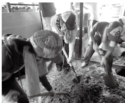
砂と砂利と水を混ぜてセメントをつくる学生たち
