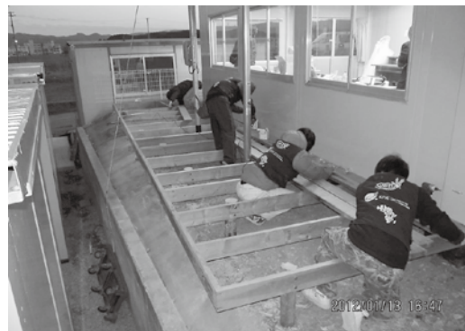
当機構の大工ボランティアらによるロジ工事の様子
