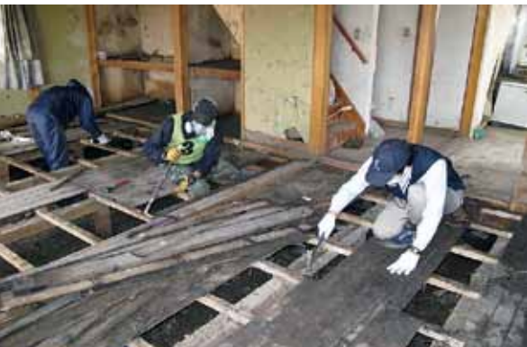
津波で浸水した住宅の床下の泥出しをするために1階の床板をはがす川口ボランティア⑥、作業は住人立ち会いで進める
