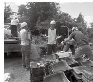
瓦礫の撤去作業の様子
